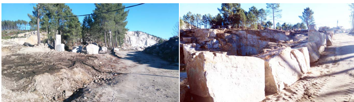
Fotos 7 e 8 – Caminho de acesso à frente de exploração Sul (ver planta de situação em anexo ). Blocos de proteção do acesso a áreas de trabalhos colocados ao longo do caminho.
