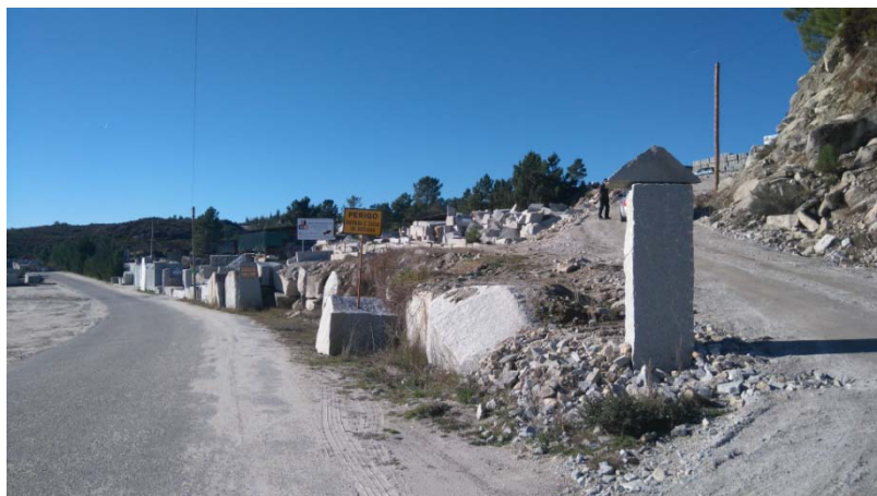
Foto 25 – Rampa de acesso à pedreira a partir da EM 1158.
