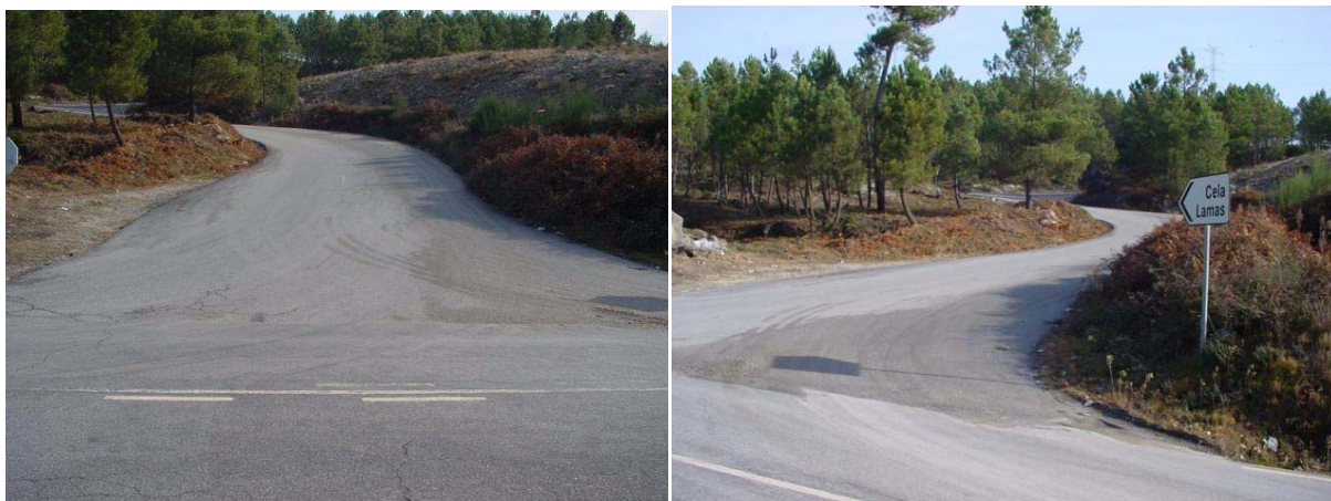
Fotos 26 e 27 – Entroncamento da EN2 com a EM1158.
