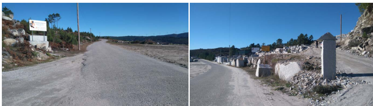
Fotos 3 e 4 – Acesso à pedreira a partir da estrada municipal EM 1158
